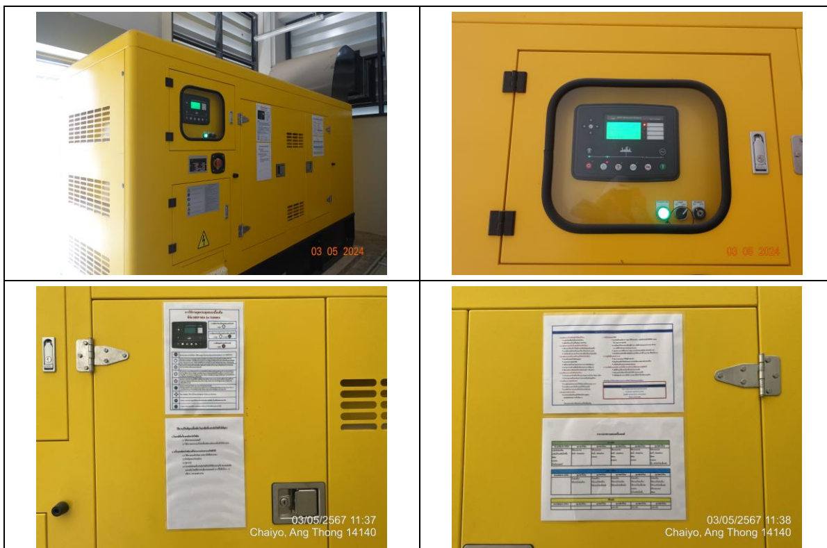
(7) ระบบไฟฟ้าสำรองสำหรับระบบบำบัดน้ำเสียส่วนกลาง
